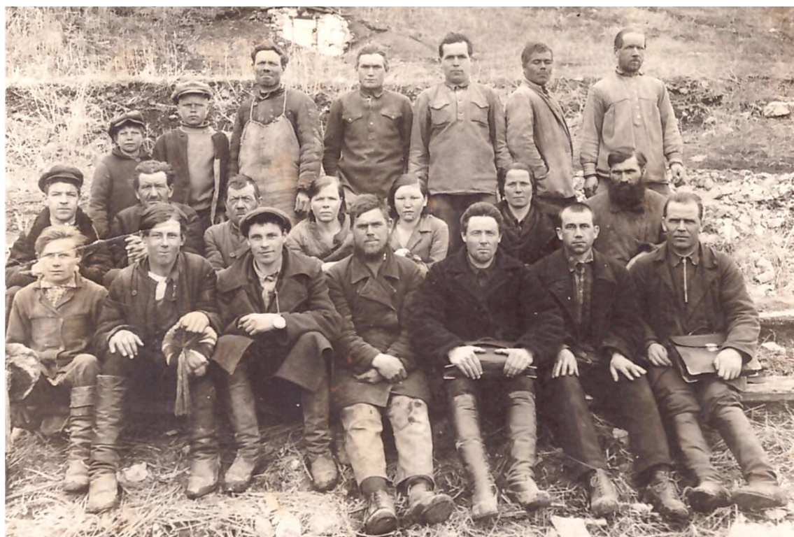
Строители кирпичного завода. с. Чемал. 1930-е гг.
