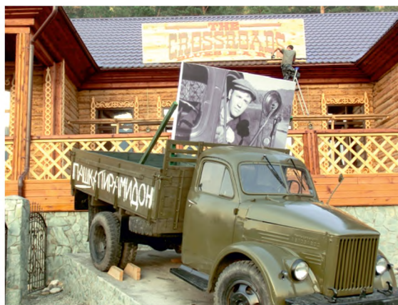
Усть-Семинская столовая после реконструкции
