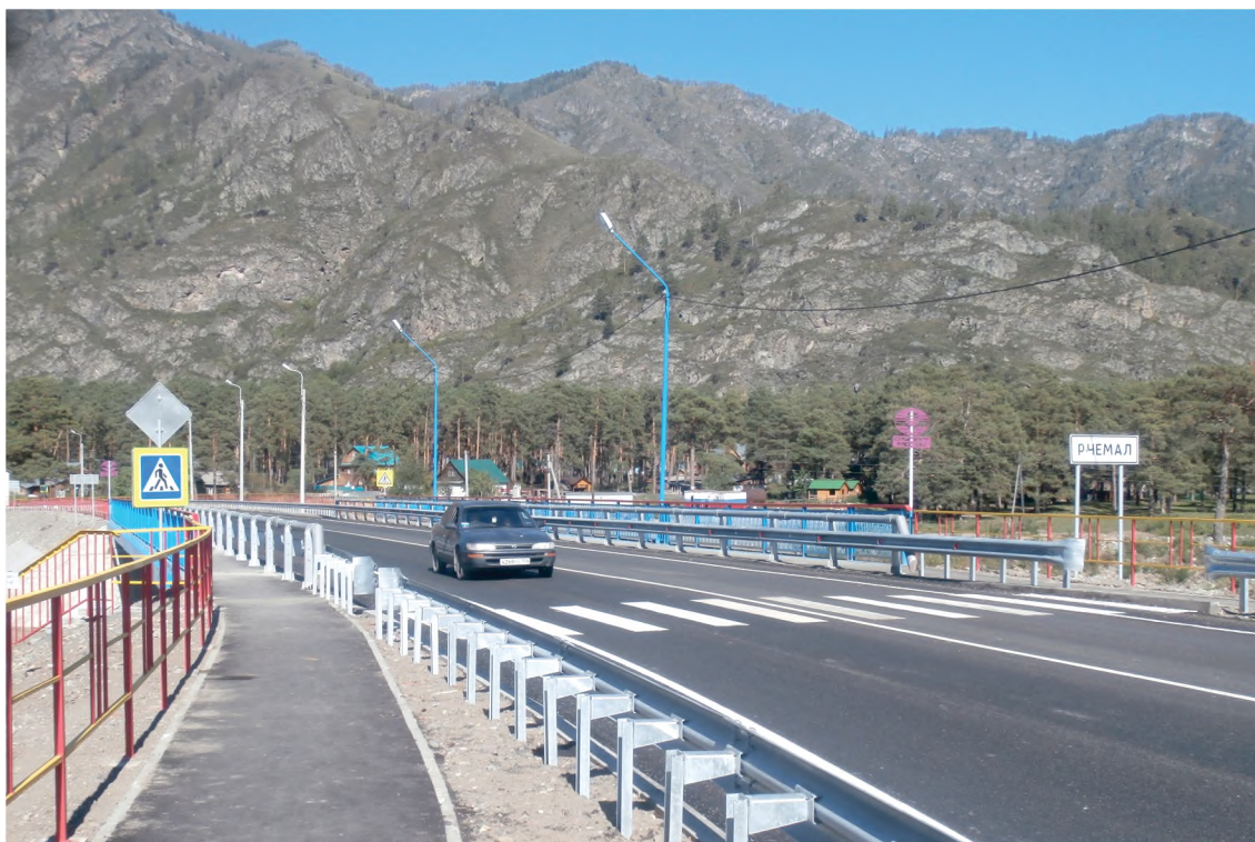
Новый мост через р. Чемал. 2016 г.
